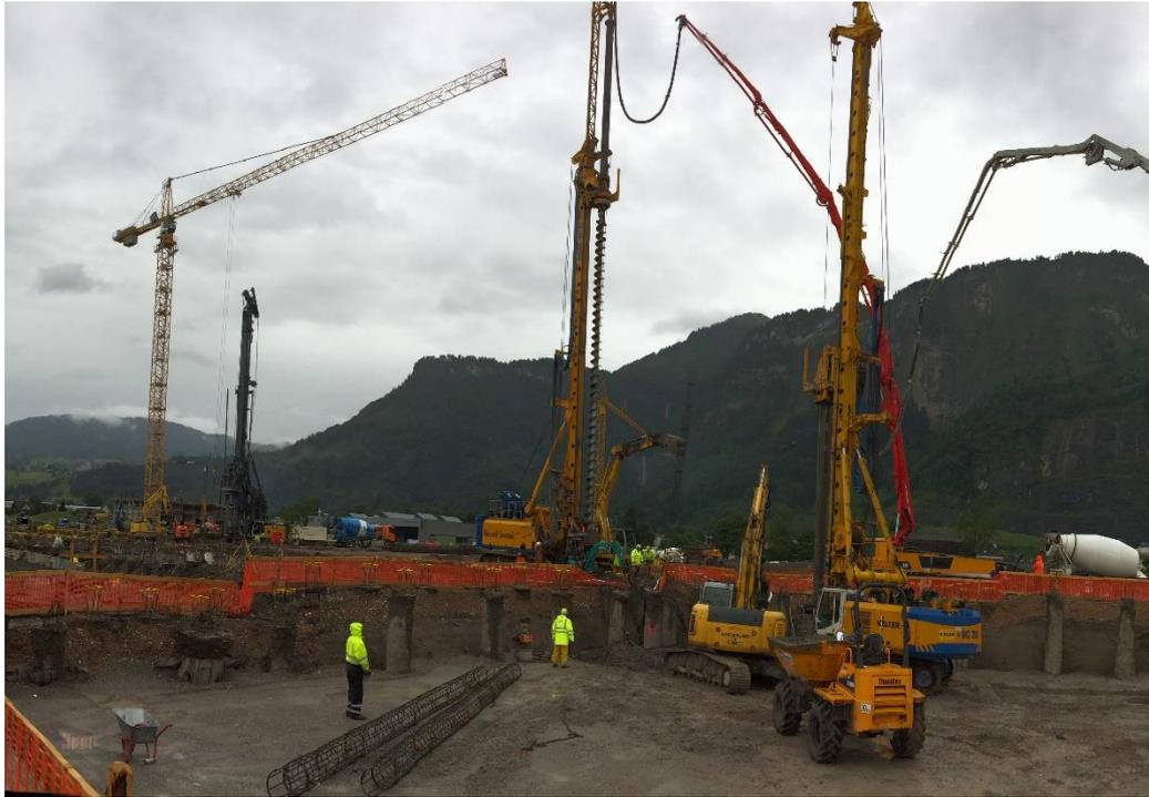
Mit dem SOB System, welches auch dichter gelagerte Kiesschichten durchhören kann, konnte gewährleistet werden, dass die Herstellung der auf Mantelreibung beanspruchten Pfähle bis in die geforderten Tiefen abgebohrt werden konnten. Als Bewehrung wurde ein Korb mit einer Länge von 10 m vorgesehen, welcher nachträglich in den Pfahl eingebracht wurde.
