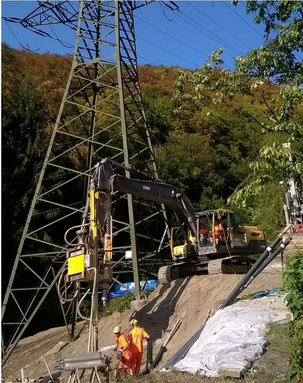
Im unwegsamen Gelände der „Donauleiten“ sind vier Maststandorte mittels Mikropfählen, System GEWI, tief zu fundieren. Das vorliegende Bodengutachten zeigt, dass unterhalb der sandig, schluffigen Auffüllung (tlw. Hangschutt) steinig, schluffiger Grobsand, teilweise mit eingelagerten Blöcken, vorliegt. Nach dem verwitterten Granit (Flinz) steht im Liegenden das kompetente Kristallin der Böhmisches Masse an.
